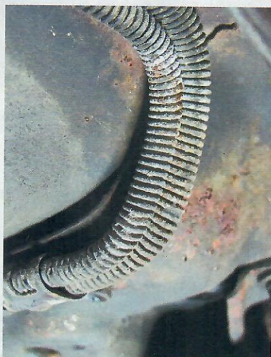
Diese Spiralen sollen Bremsleitungen vor Steinschlag schützen, fördern aber Rost
