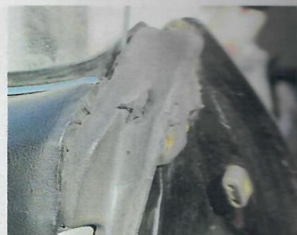
Dichtgummis an den Türen lösen sich auf, sind aber problemlos zu bekommen
